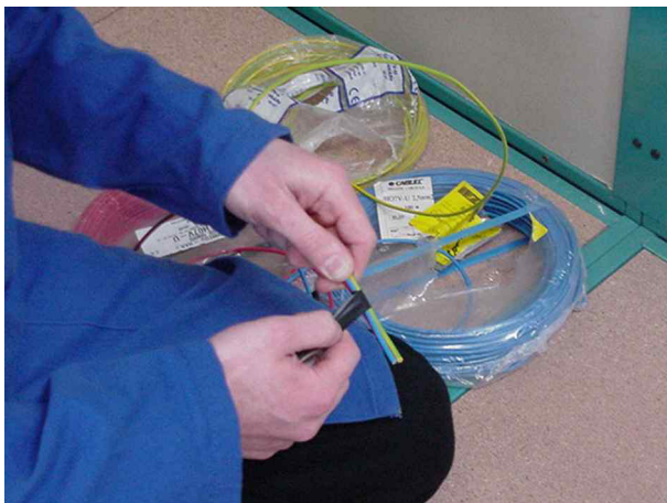
1. Aligner les conducteurs (non dénudés) à enfiler dans la gaine, puis faire, au moins sur 5 cm de longueur, des tours de chatterton pour maintenir les conducteurs entre eux.
