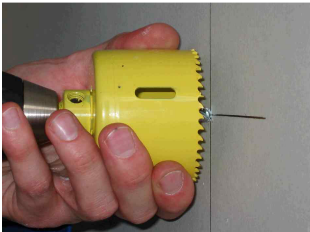
3. Centrage du foret sur le traçage
