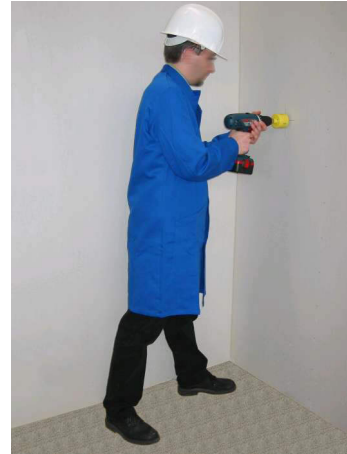
2. Prendre une posture pour avoir la meilleure stabilité possible lors du perçage et vérifier le sens de rotation de la perceuse (sens de vissage : ↻)
