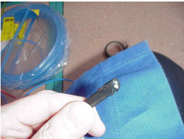
2. Pour éviter que les conducteurs ne se coincent dans la gaine, il est nécessaire de faire un bout arrondi avec du chatterton.
