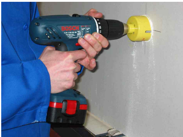
5. Perçage en gardant l'alignement vertical et horizontal
