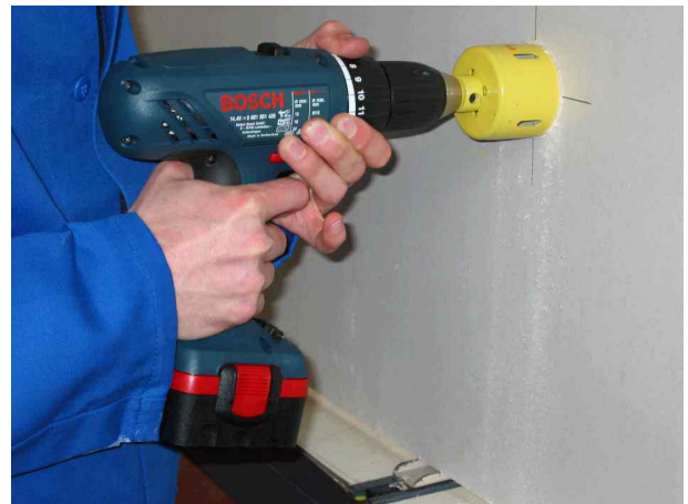
4. Alignement de la perceuse (en horizontal et en vertical)
