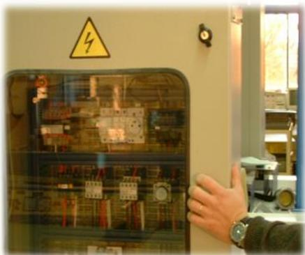
L'obstacle (en matériau conducteur ou isolant) placé entre la personne et les pièces nues sous tension (ici l'armoire) évite tous contacts directs avec ces pièces.
