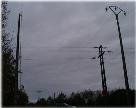
Les pièces sous tension , (ici les conducteurs de 2 lignes (63KV,20KV ) sont placées suffisamment haut pour être hors d'atteinte des personnes
